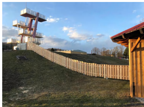
Errichtung eines neuen Holzzauns
