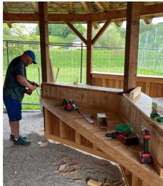
Markus Praschek bei der Fertigstellung der Bar
